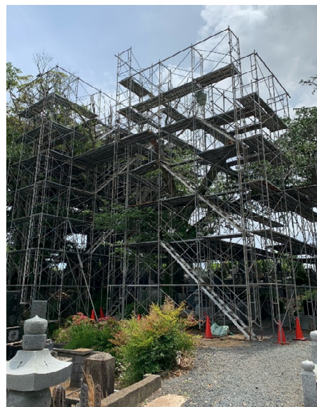
大きな足場を組んでの作業になりました
